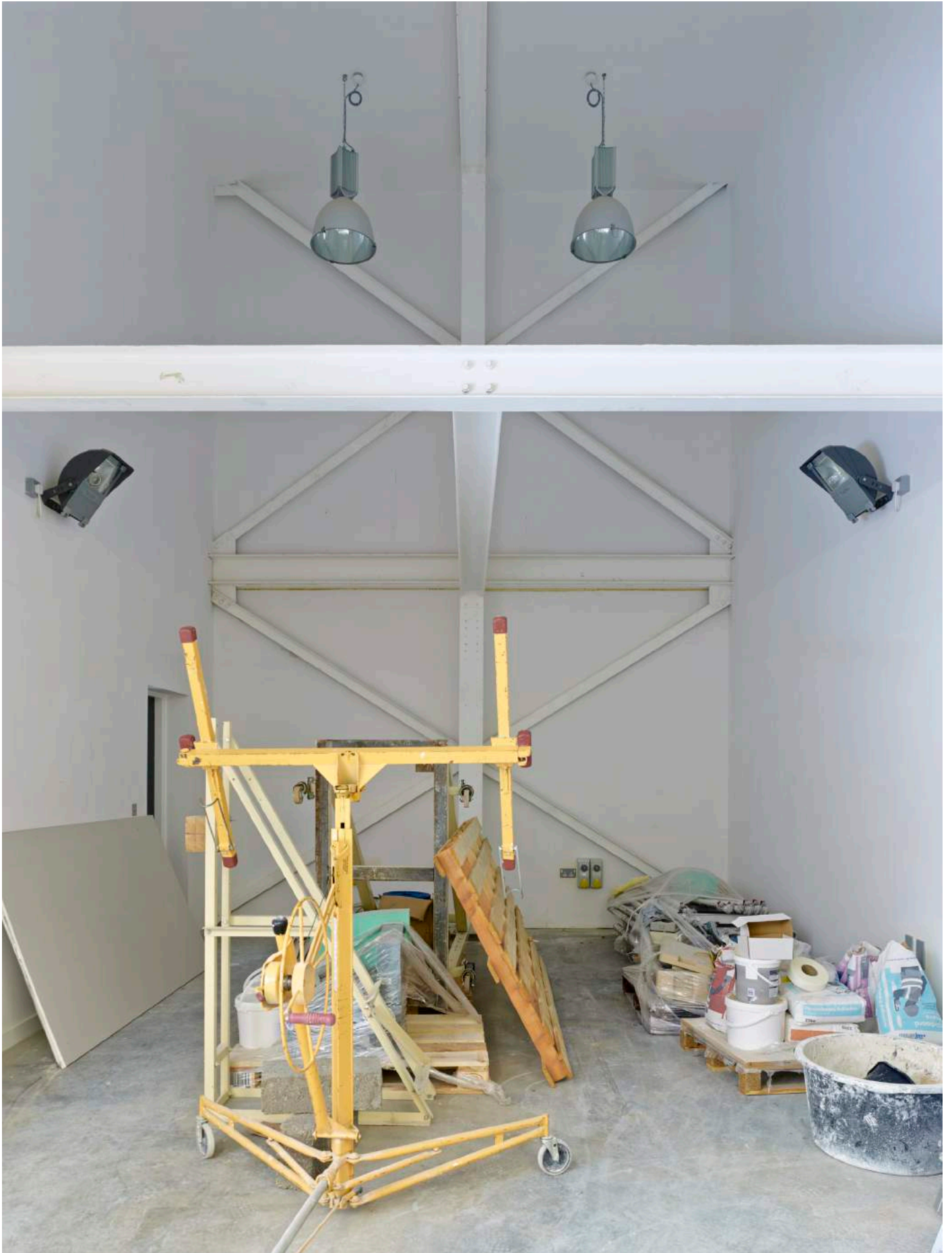
Drywall Test Rig
